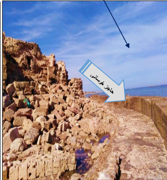
الصورة (180) الحاجز الخرساني للحد من فعل التعرية البحرية.
