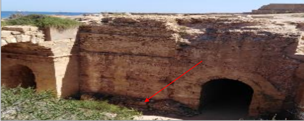
الصورة (49) التفكك الحبيبي بالبواباء الغربية (بواباء الموت) بحلباء المصارعاء بللباء.
