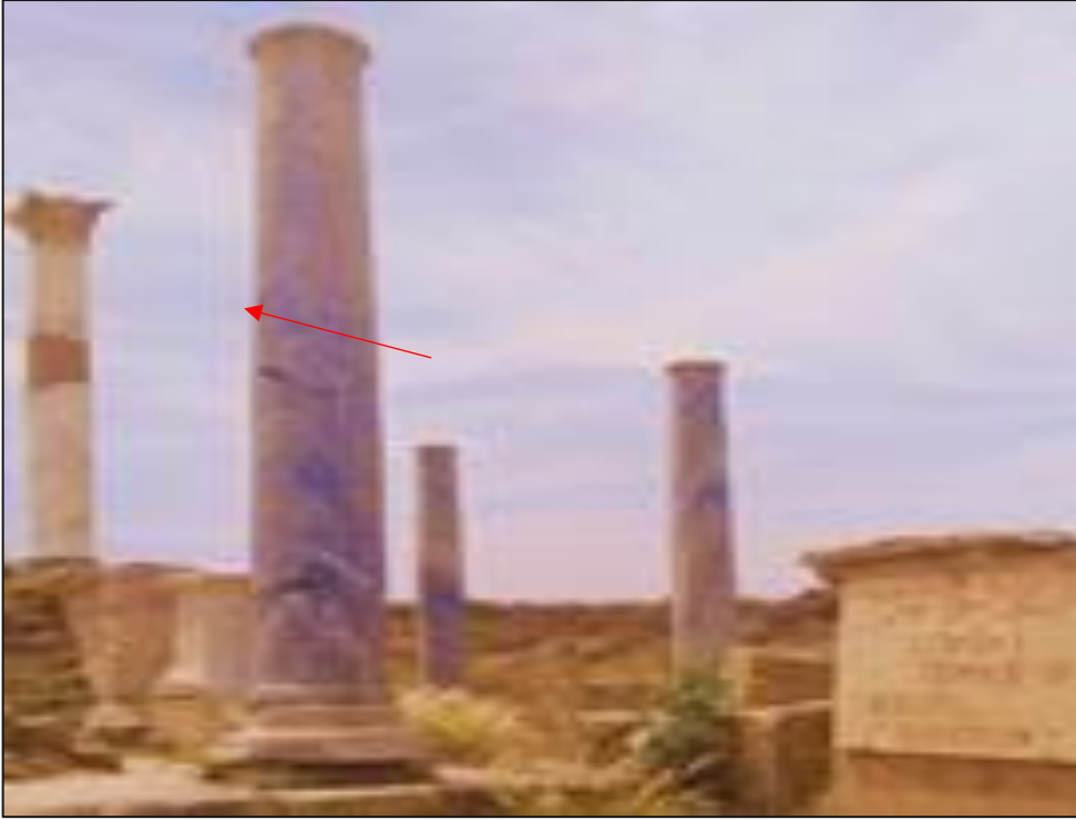
الصورة (44) التقشر في أعمدة معبد ليبرياتر بلبدة.
