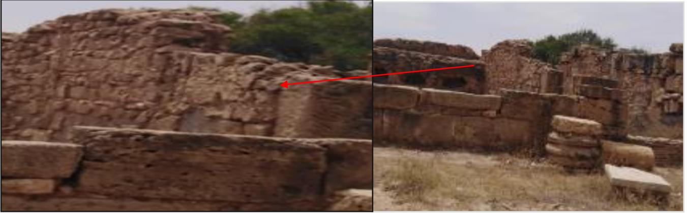
الصورة (48) التفكك الحبيبي بالجدار الجنوبي لمسرح لبداء الأثري
