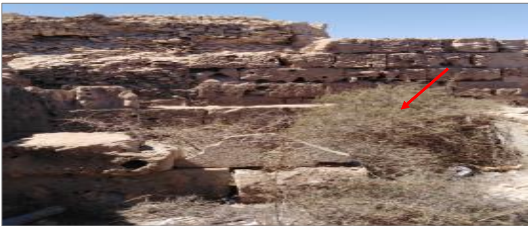
الصورة (50) التفكك الحبيبي بالسور المؤءى لمعاصر الزىءون بمءىنة صبراءة الأءرىة.
